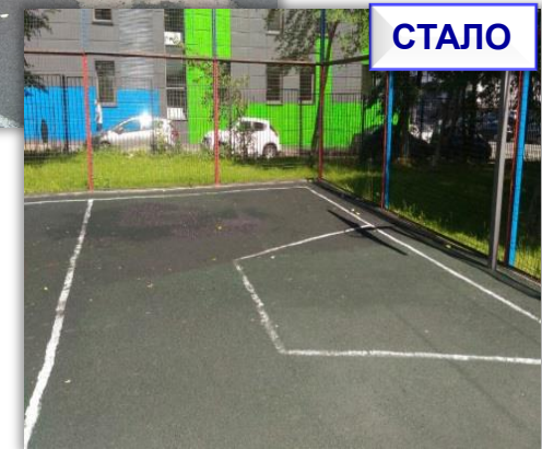
САО, Ленинградское ш. д. 56А – восстановлено покрытие, окрашено ограждение спортплощадки - ГБОУ ДПО ЦВПГВ
