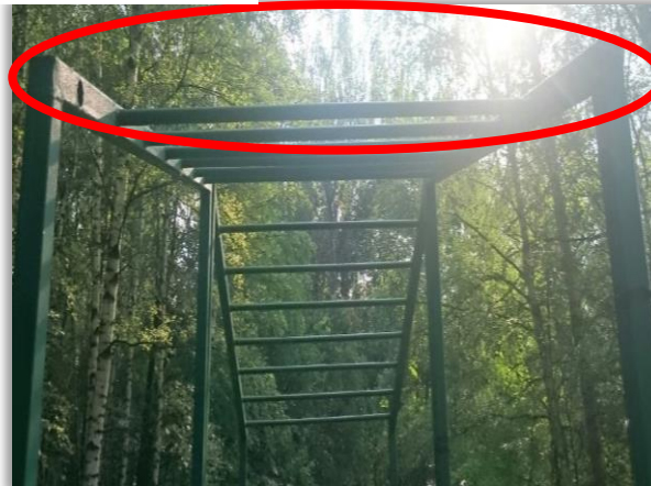
ЛЗ «Тропаревский», поврежден спортивный тренажер (отсутствует перекладина) –ГПБУ «Мосприрода»
