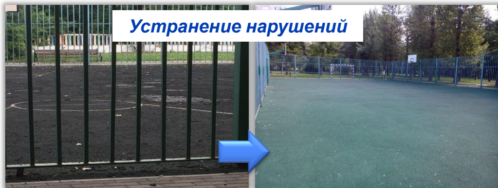
ЗАО , Боровский проезд д.8 – выполнен ремонт покрытия на спортивной площадке. Отв. ГБУ «Жилищник района Солнцево»
